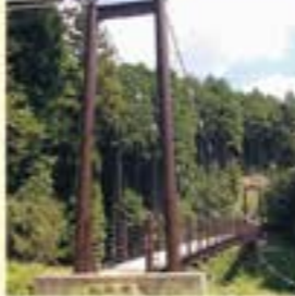
④丘陵地にある、高さ15mの吊り橋
