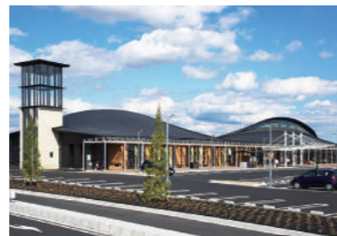
新4号国道沿いの道の駅しもつけ
