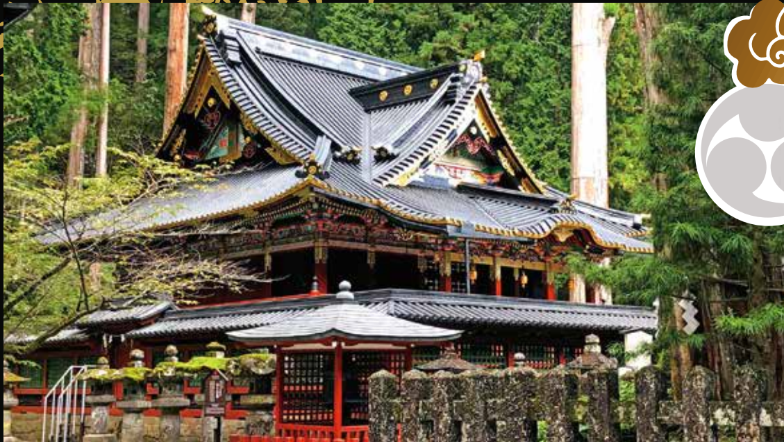
▲黒漆塗りの屋根、弁柄漆塗りの柱、銕金具などの修理を終えて輝きを放つ本殿
