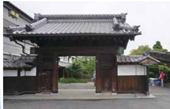
松本家表門 C-5 大型の表門で、組物間や妻飾に精緻な彫刻を飾り、袖堀とともに豪華な構えを見ることが出来ます。
