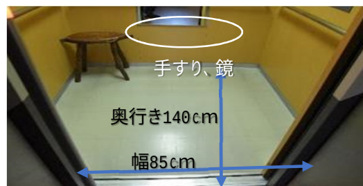
エレベーター
