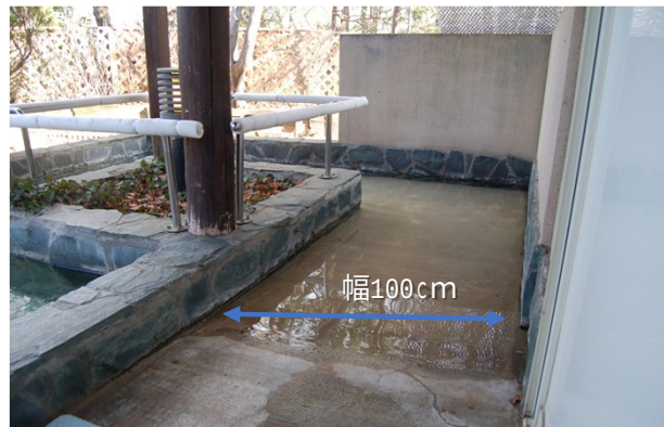
浴槽へのスロープ部分
