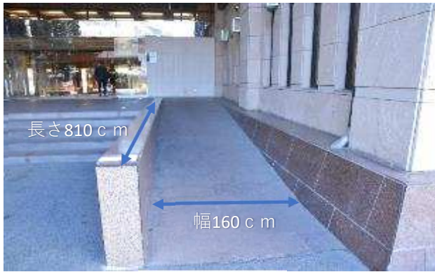
玄関スロープ
