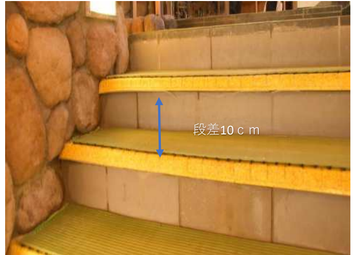
大浴場（内部入口）
